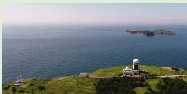
Станция ГСА Госан
