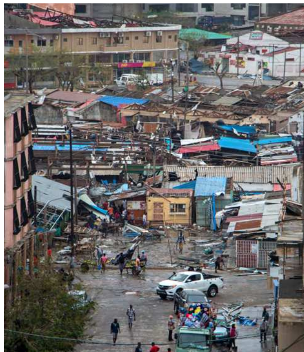
Рисунок 4. После прохождения сильного циклона «Идай» след разрушений, оставленный в городе Бейра, был очень заметен. Крыши были просто сорваны, ничего не осталось прежним (Источник: iStock/ Дуарте Говейя)
