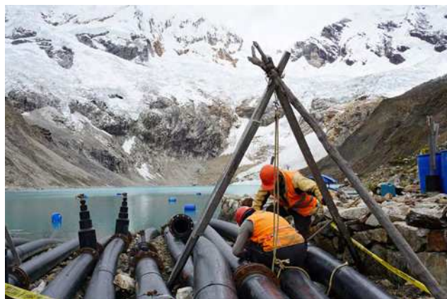
Рисунок 7. Ледниковое озеро Палькакоча (Перу) дренируется с помощью сифонов, чтобы избежать наводнений, вызванных прорывом ледниковых озёр (НПЛО фото: Кристиан Хуггел).
