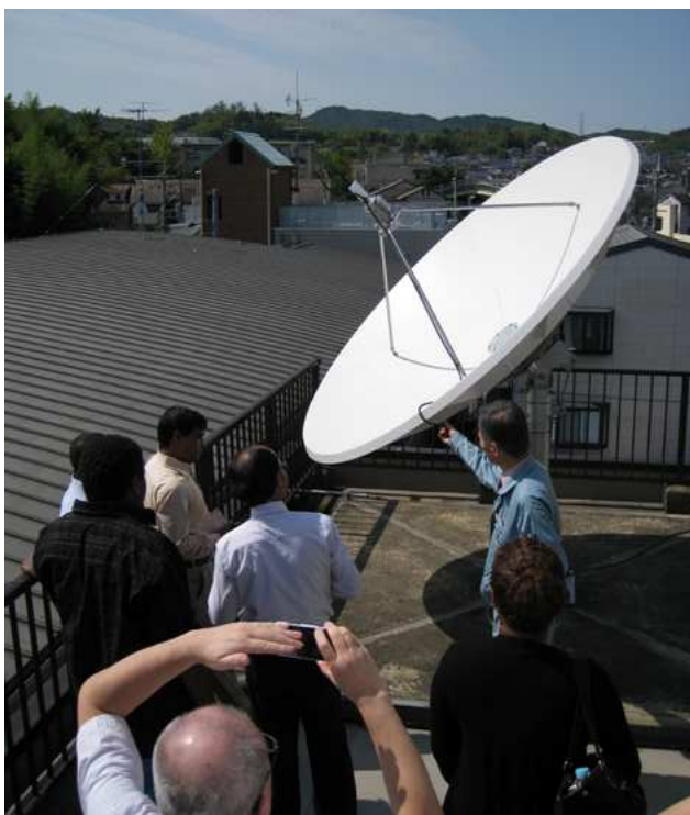
Системы включают антенну приема спутниковых данных (диаметром 2,4 м), компьютер для сбора данных и отдельный компьютер для формирования и визуализации продукции.
