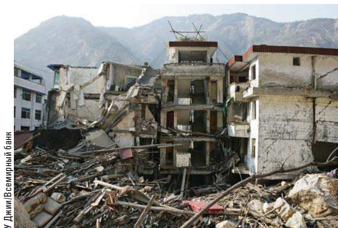
Разрушенные здания после землетрясения в провинции Сычуань, Китай, в 2008 г.
