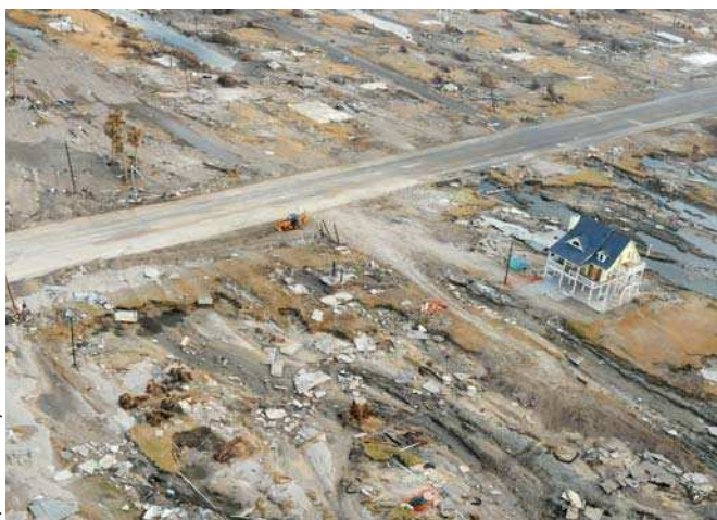
Единственный дом, уцелевший после урагана «Айк» (2008 г.), который полностью разрушил населенные пункты Джилккрайст и Галвестон, штат Техас. Учитывая урок, преподнесенный ураганом «Рита» в 2005 г., дом построили на возвышении и спроектировали так, чтобы он выдерживал скорость ветра до 209 км/час.
