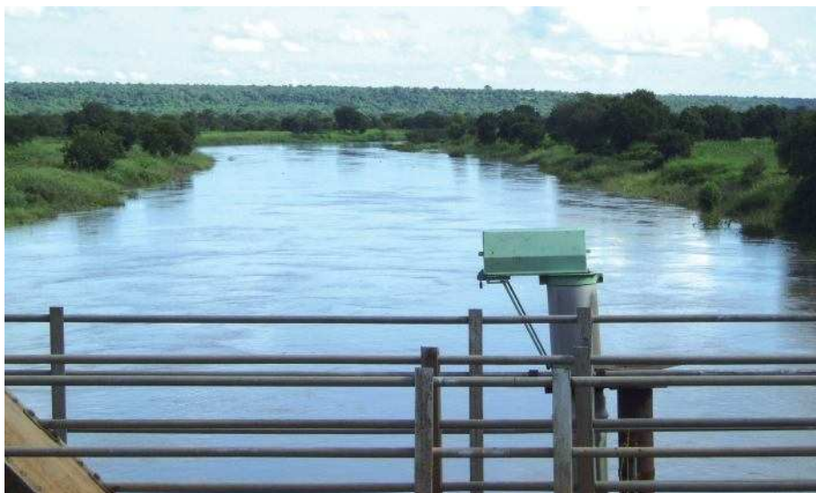
Установленный автоматический регистратор уровня воды
