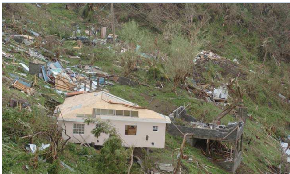
Ущерб от урагана на Гренаде в 2004 г.: более 90% зданий острова оказались разрушенными.
