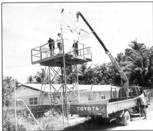
Тарава, Кирибати — Инженеры Метеорологической службы Новой Зеландии помогают провести замену радиолокационной станции зондирования верхней атмосферы на другую, основанную на ГСOM
