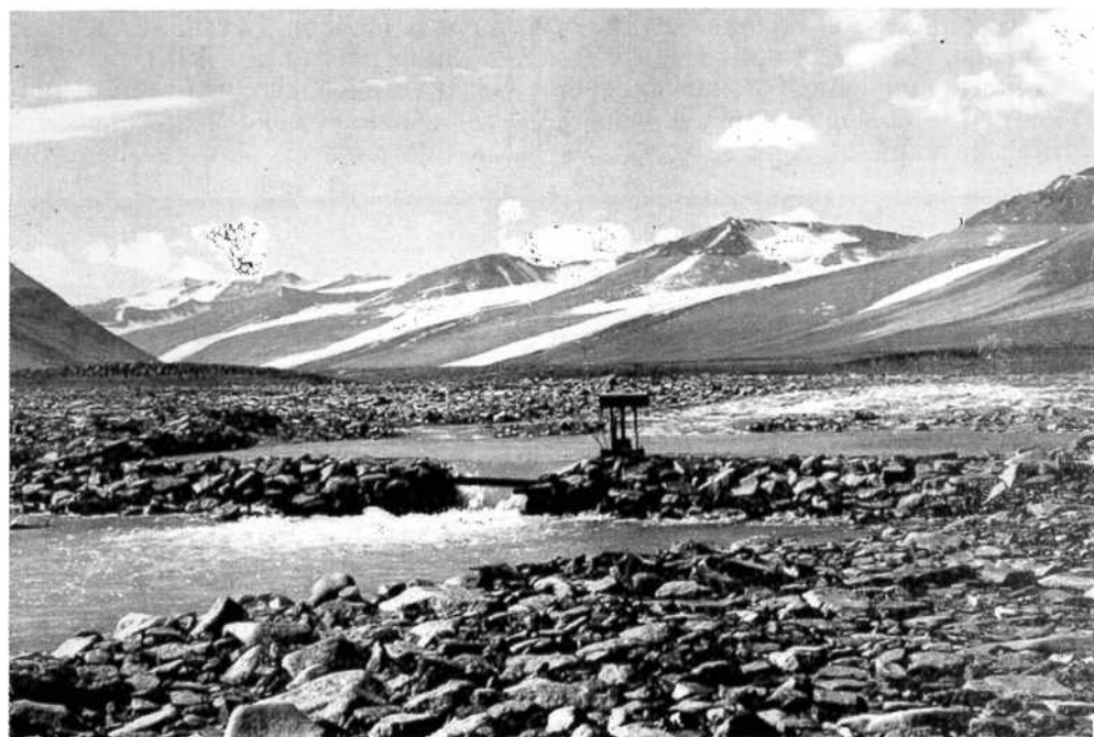
Рис. 2 — Река Оникс вблизи Ванда Вее ( 77^{\circ}31'40'' ю. ш.). Здесь расположена самая южная в мире водомерная станция
