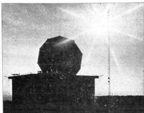
Метеорорадиолокатор С-диапазона, установленный в Хамелдон-Хилл (первая полностью автоматизированная сеть в Соединенном Королевстве)
