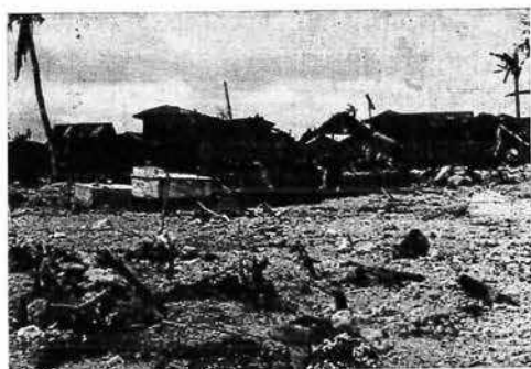
Балангкаян, восточный Самар, Филиппины, 1988 г. — Опустошения, вызванные штормовым нагоном при прохождении тайфуна 8819 Йонинг; перевернуты даже бетонные тумбы
