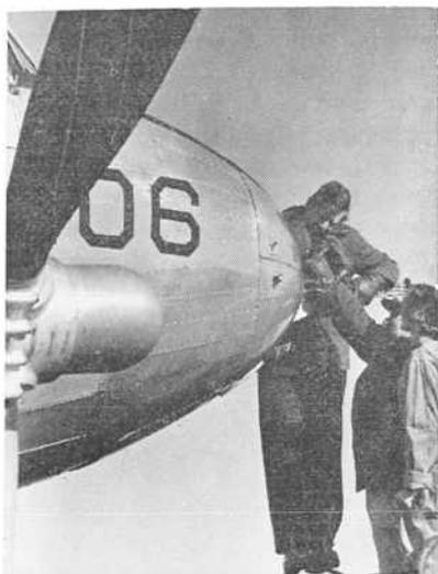
*Вудс-Хол, 1957 г.*— Для измерения турбулентных движений внутри кучевых облаков и под ними самолет DC-3 оборудован специальной выносной мачтой, установленной в носовой части
