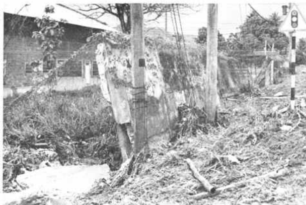
Тринидад — Стена, подмытая сильным дождем в июле 1984 г.
