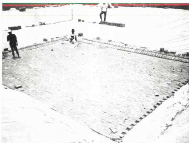
Индонезия — Строительство водохранилища, облицованного полиэтиленом и глиняными кирпичами, которое предназначено для накопления дождевой воды в провинции Западная Ява (Фото: М. W. Baradas)
