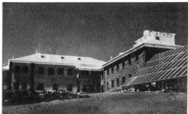
Новая базовая станция БАПМоН в Изање (2367 м над ур. м.) на Тенерифе, Канарские острова (Испания)
