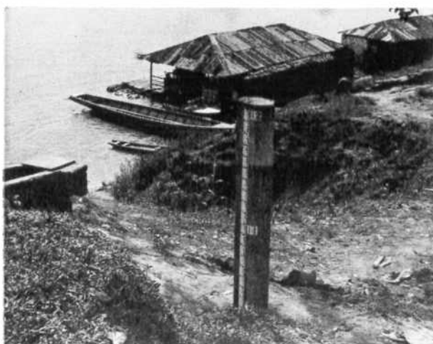
Перу — Строительство гидрологической станции в Тамшияку на Амазонке, вверх по течению от Икитоса
