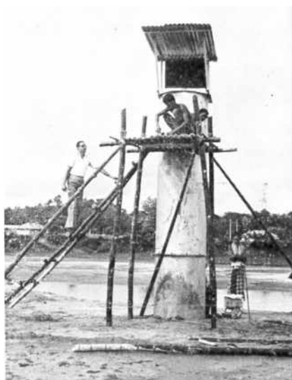
Бангладеш — Установка регистратора уровня воды в Ламе на р. Матамухури в районе Хяла-Трэкте в Читтагонге
