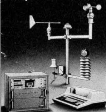
Сбор данных с помощью микропроцессора, основной блок с 19 каналами, возможность расширения системы, система для измерений с переменным интервалом, регистрация экстремальных значений, контроль пороговых значений, кварцевые часы с календарем на несколько лет.
