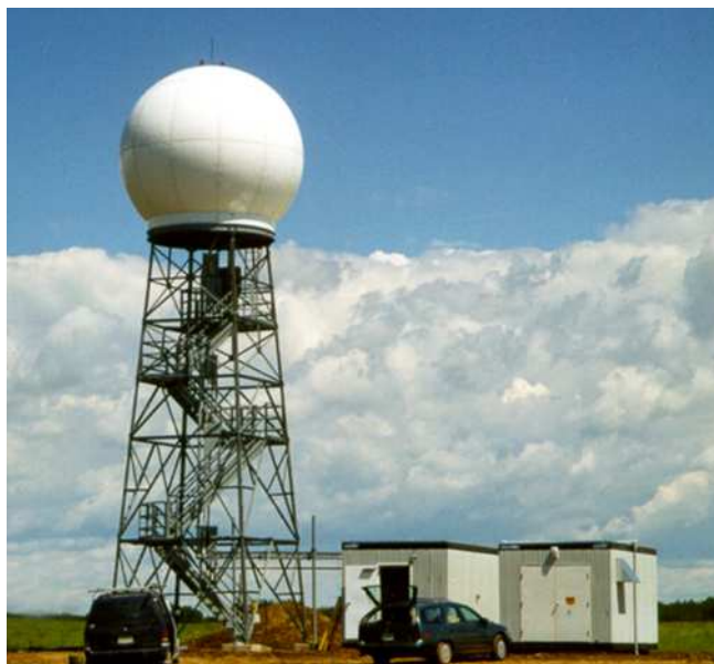
Рисунок 7.1. Типовой метеорологический радиолокатор в составе канадской сети. Показаны основные физические компоненты радиолокационной системы. Высота вышки около 30 м с обтекателем, на котором установлены предупредительные световые сигналы и громоотвод.
