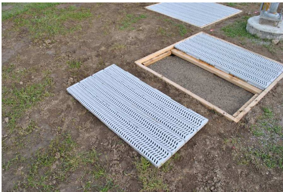
Рисунок 2.10. Целевая область из серого перфорированного и текстурированного пластика во время строительства. Панели размером примерно 1,2 м x 1,2 м устанавливаются на деревянную раму (фото предоставлено Министерством охраны окружающей среды Канады).
