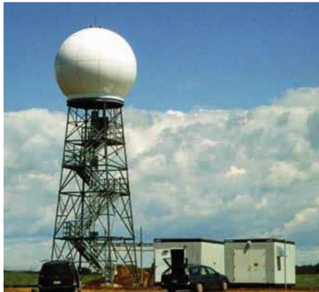
**Рисунок 7.1. Типовой метеорологический радиолокатор в составе канадской сети. Показаны основные физические компоненты радиолокационной системы. Высота вышки около 30 м с обтекателем, на котором установлены предупредительные световые сигналы и громоотвод.**
