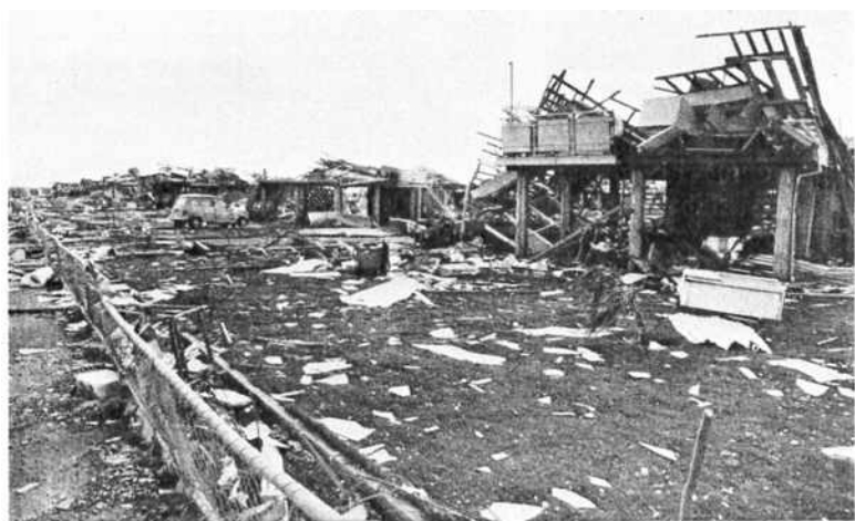
Рис. 1 — Разрушения, произведенные ветром при прохождении циклона Трейси . Дарвин, Австралия, декабрь 1974 г. На целой улице дома опустошены, верхние этажи полностью разрушены (Фото: The Herald and Weekly Times Ltd., Мельбурн, Австралия )
