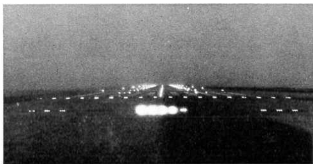
Рис. 3 — Снимок сделан с того же места, что и снимок на рис. 2 , после включения системы TURBOCLAIR. Видимость на взлетно-посадочной полосе увеличилась до 700 или 800 м
