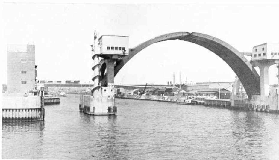
Япония: Барьер от штормовых волн, представляющий часть системы по защите от тайфуна низко лежащих областей Осаки. Барьер опускают, когда ожидаются штормовые волны
