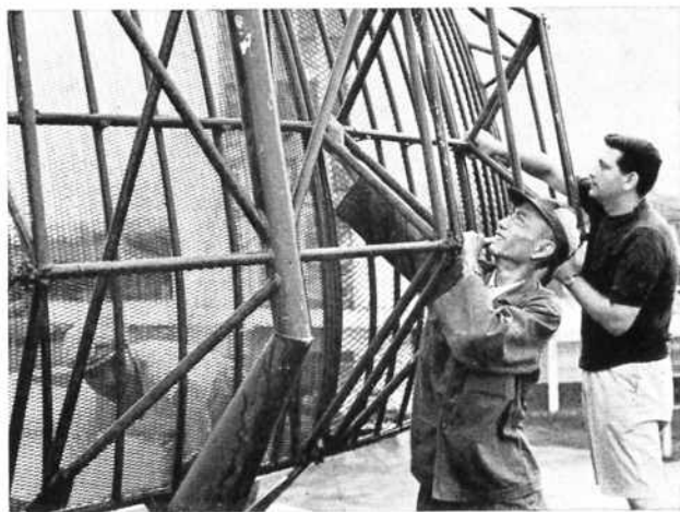
Хуалянь, Тайвань. Установка радиолокационной станции. Справа — г-н У. Гильберт, эксперт ВМО по электронным приборам.
