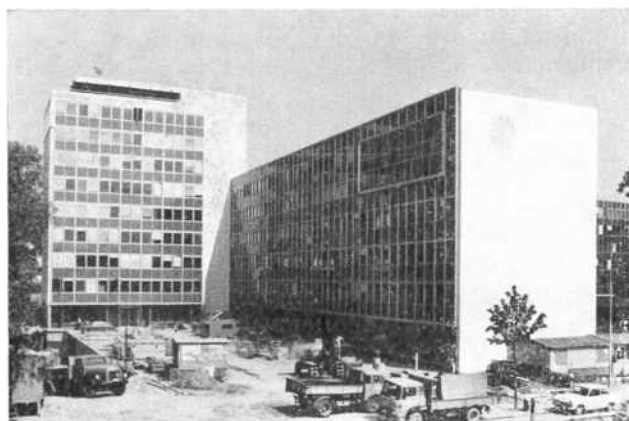
Женева: Строительство пристройки к зданию штаб-квартиры ВМО, июль 1970 г.
