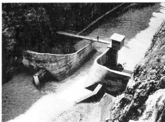
Швейцария: Водомерный пост на реке Масса, который посетили в сентябре 1969 г. члены консультативной рабочей группы КГМ и группа экспертов ИК.
