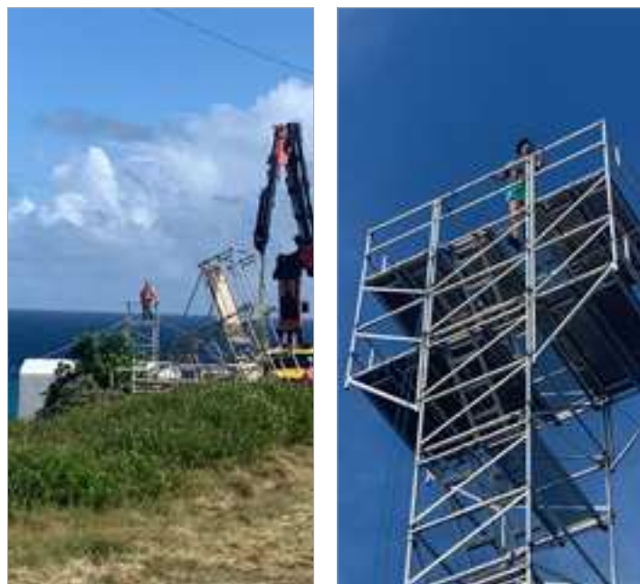
Рисунок 15. Демонтаж старой башни (слева); д-р Гастон на вершине вновь возведенной башни (справа), конец января 2024 г.
