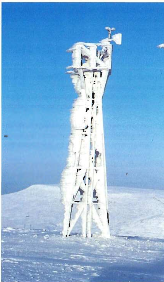
Обледеневшая вышка анемометра. An iced anemometer tower.
