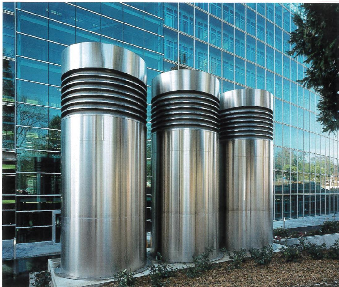
Холодный свежий воздух (зеленый цвет) хранится под зданием для подачи его в случае необходимости для охлаждения (голубой цвет). Использованный воздух вытягивается из каждого помещения (красный цвет). В холодную погоду подогретый воздух фильтруется и циркулирует через те же трубы и вентиляционные проёмы.
