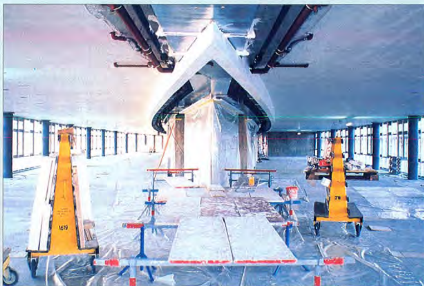
Внутреннее пространство нового здания начинает приобретать определенную форму (Архитектурная мастерская, Р. Бродбек, архитектор FAS; Дж. Руле, архитектор SIA AGA FAS)
