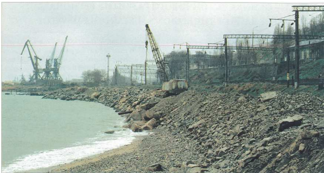
Работы по защите железной дороги от наступления моря в Махачкале, Россия (РОСГИДРОМЕТ)
