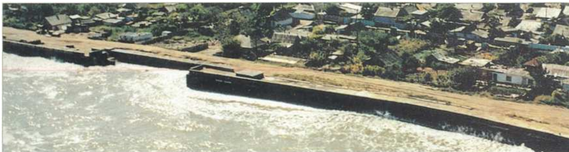
Береговые защитные сооружения в Дербенте, Россия (РОСГИДРОМЕТ)
