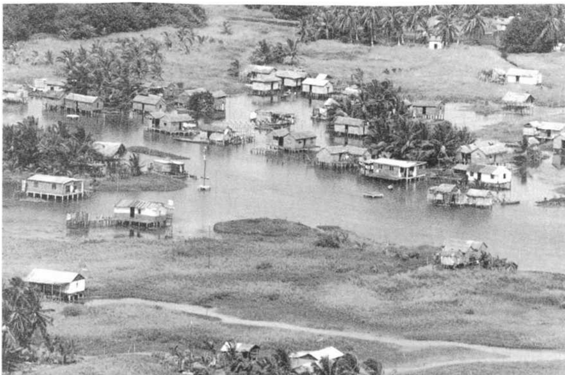
В некоторых районах, подверженных наводнениям, ущерб и потери имущества избегаются путем превышения фундамента зданий над ожидаемым уровнем затопления. (Гарри Фромм)
