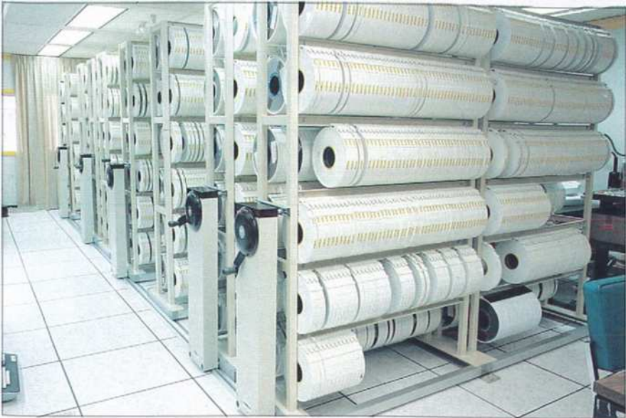
Типовой климатический архив. Климатические данные по Канаде хранятся на 10000 катушек магнитных лент длиной 2400 футов каждая
