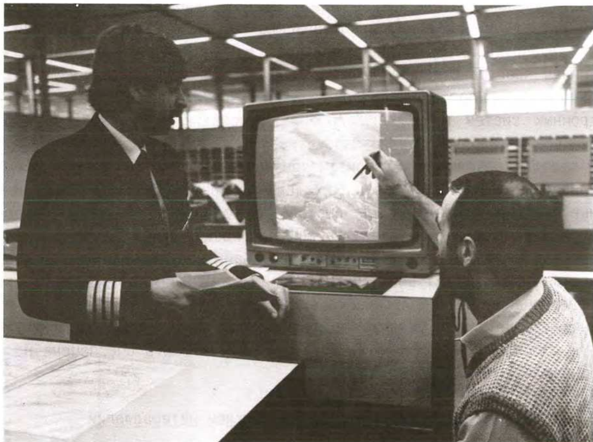
Использование метеорологических данных, передаваемых спутником, в планировании полетов. Данные передаются на видеотерминал спутником МЕТЕОСАТ-П (фото: Люфтганза)
