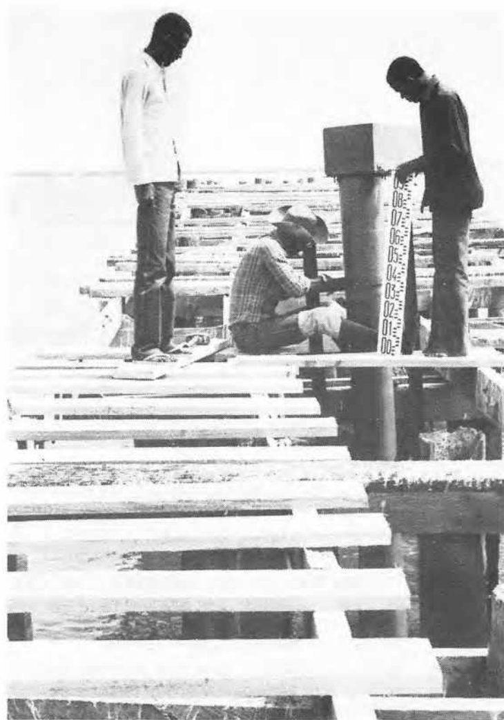
Рис. 36 — Строительство гидрологической станции в эстуарии реки Салум в Фуондиунге (Сенегал) для наблюдений за соленостью и уровнем воды (Фото : Цкуткицки, АГРГИМЕТ)
