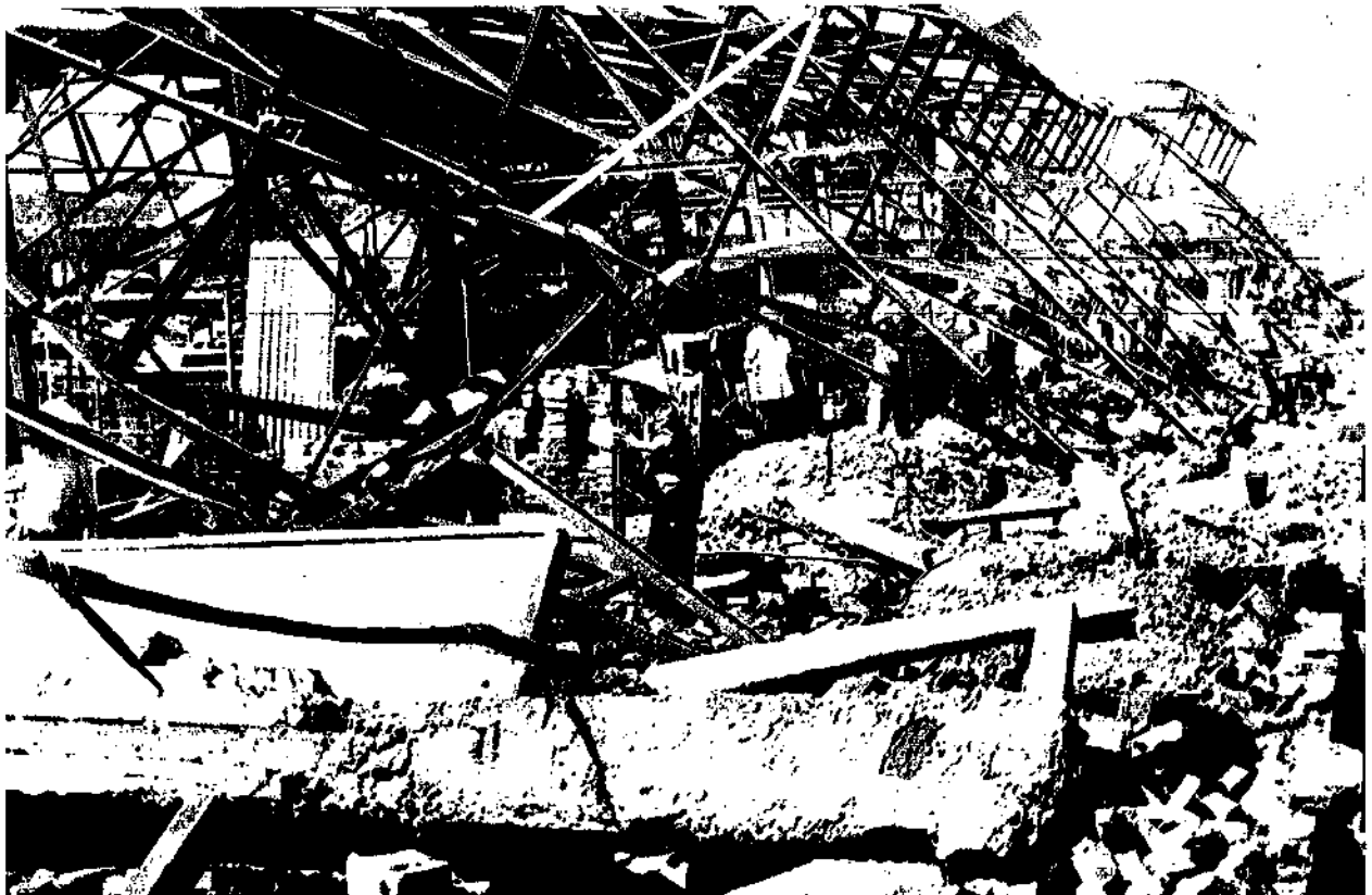
Разрушения, вызванные тайфуном ВАИНЕ во Вьетнаме в сентябре 1986 г. (фото: Лига Обществ Красного Креста)
