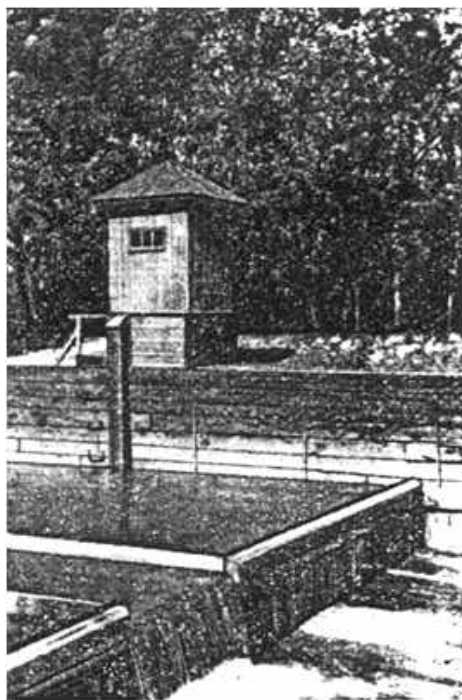
Рис.IX.4. Общий вид расходомера с прямоугольным водосливом без бокового сжатия (УГМС Украинской ССР)
