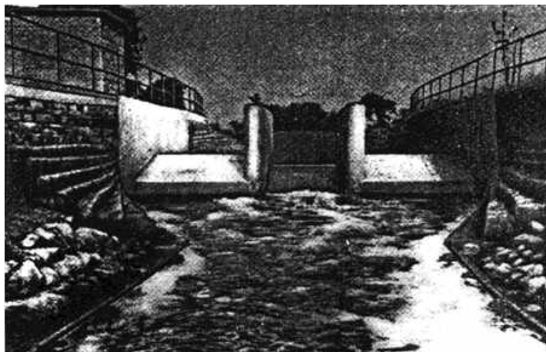
Рис.VIII.3. Общий вид водослива треугольного профиля с несколькими водосливными отверстиями
