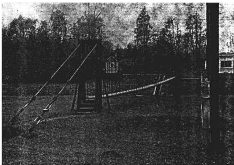
Рис.41. Гидрометрический мостик подвесного типа
