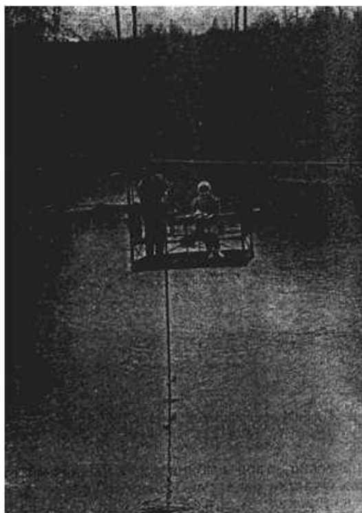
Рис.42. Измерение расхода воды с люльки
