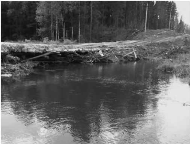
Рисунок Ж.2 — Строительство бревенчатого перехода временной технологической дороги через малую реку
