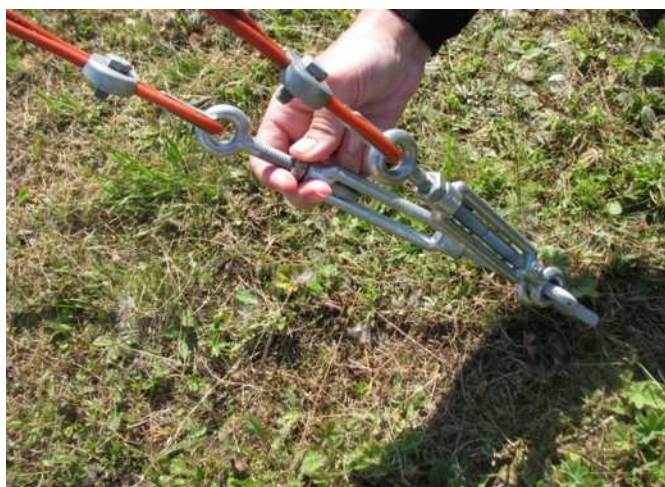
Рисунок 7.3 – Оттяжки на мачте АМК
