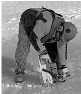
Рис. 2.73. Вырезание консольной балки цепной бензопилой.
