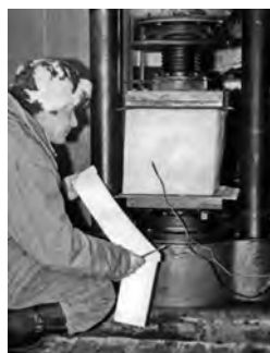
Рис. 2.24. Калибровка сферического датчика давления, вмороженного в куб льда в прессе.
