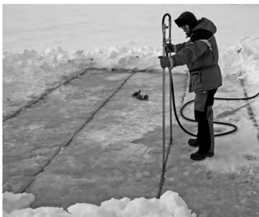
Рис. 2.68. Вырезание консольной балки при помощи ледореза.
