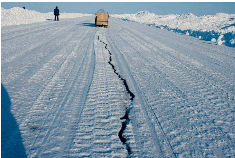
Рис. 17. Продольная трещина, образовавшаяся в процессе расчистки ледовой дороги.
