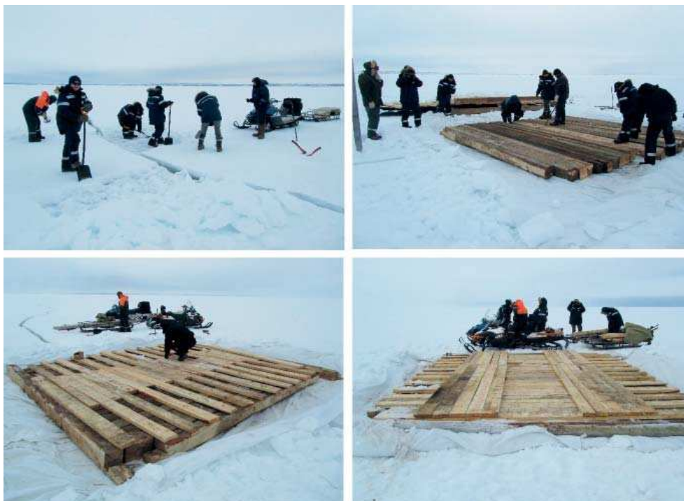
Рис. 12. Монтаж временного моста из бруса и досок через трещину шириной 50 см (припай о-ва Котельный).
