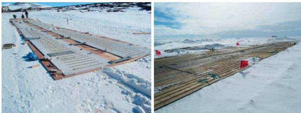
Рис. 5. Примеры обустройства верхнего строения поверх уплотненных снежных выездов с берега на лед.
