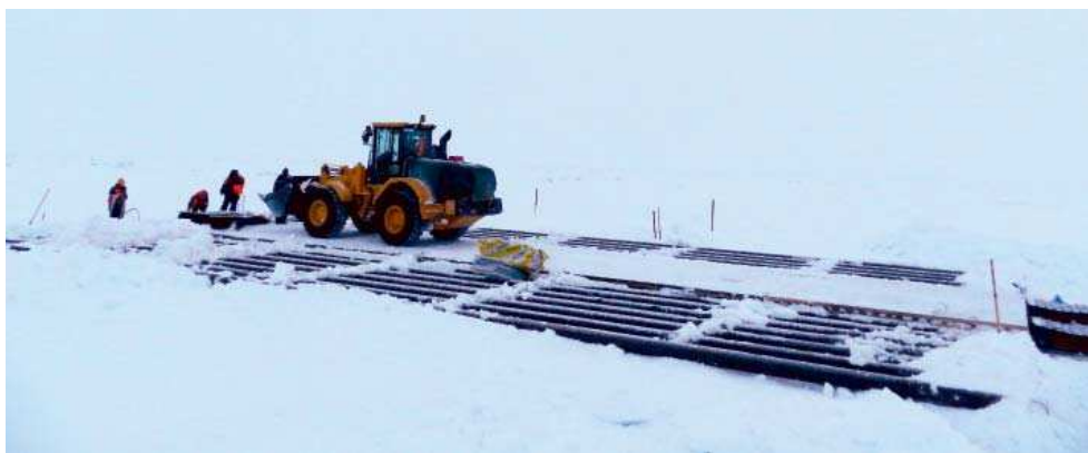
Рис. 13. Временный мост из сваренных стальных труб с деревянным верхним строением через широкую трещину (припай о-ва Котельный).
