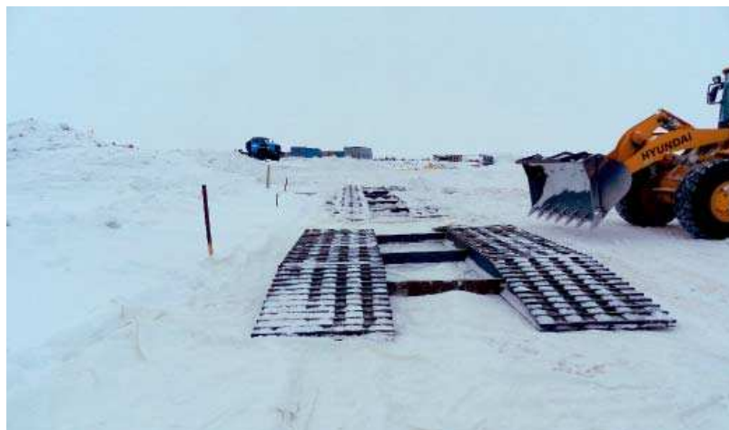
Рис. 11. Установка временных колежных стальных мостов на приливных трещинах (припай о-ва Котельный).
