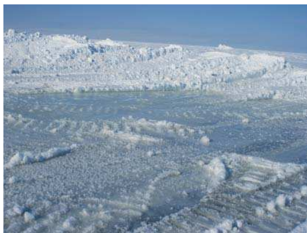
Рис. 18. Вода, выступившая из-под скопления снега на краю ледовой дороги.
