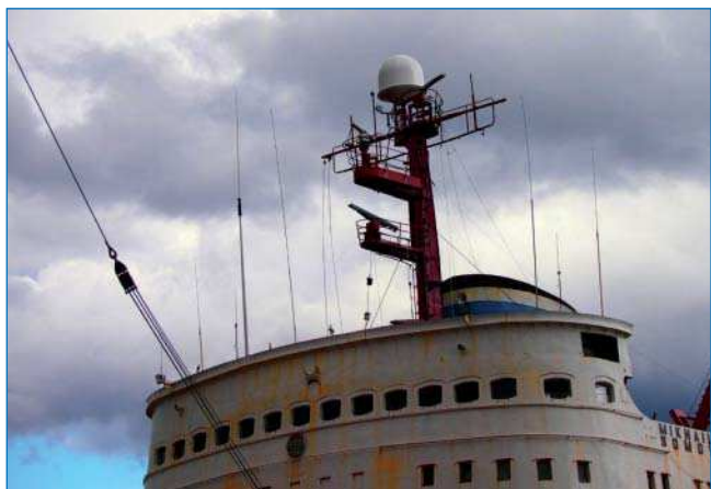
Станция VSAT, смонтированная на НЭС «Михаил Сомов».
