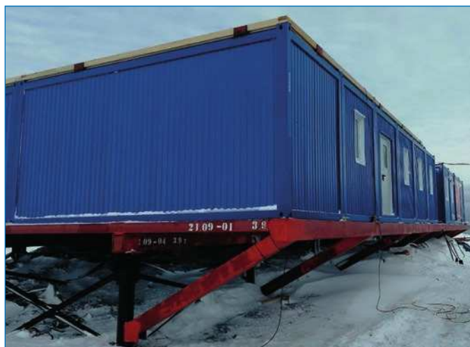
Новое здание сезонного модульного комплекса крупным планом
