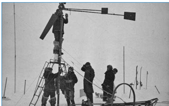
Установка ветряного двигателя в полярном лагере
