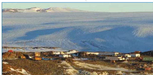
Общий вид станции Новолазаревская. Фото автора
