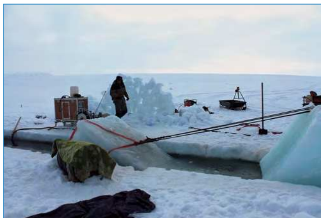
Установка на дно второго ледяного блока
