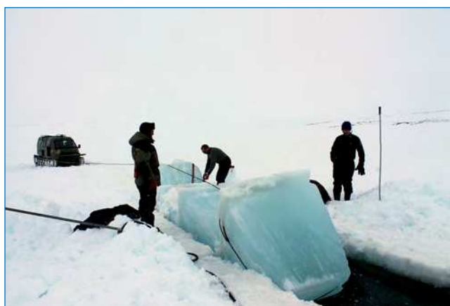
Следующий этап — жесткая фиксация крайнего блока в прижатом положении во избежание его отклонения под своим весом
