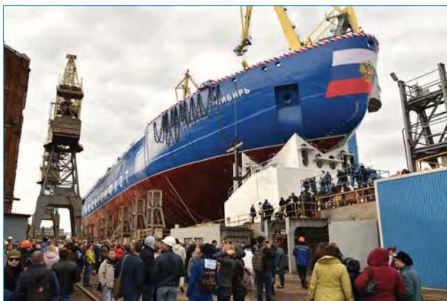
Корпус атомного ледокола «Сибирь» на стапеле.
