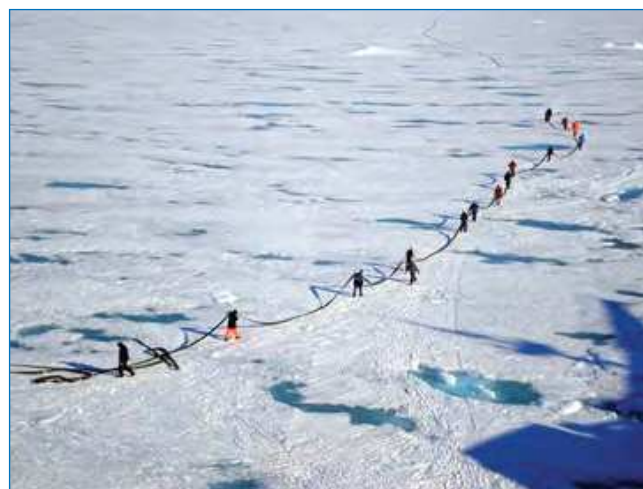
Рис. 2. Прокладка топливной шланговой линии в бухте Тала.
