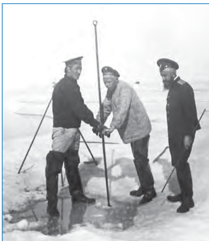
Измерение толщины льда. Справа А.М. Лавров. 1915 год (фото из архива Н.И. Евгенова)
