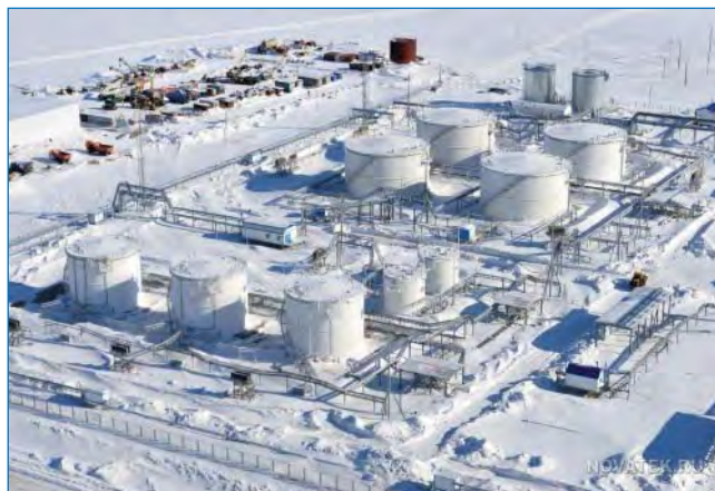
Строительная площадка завода «Ямал СПГ»
