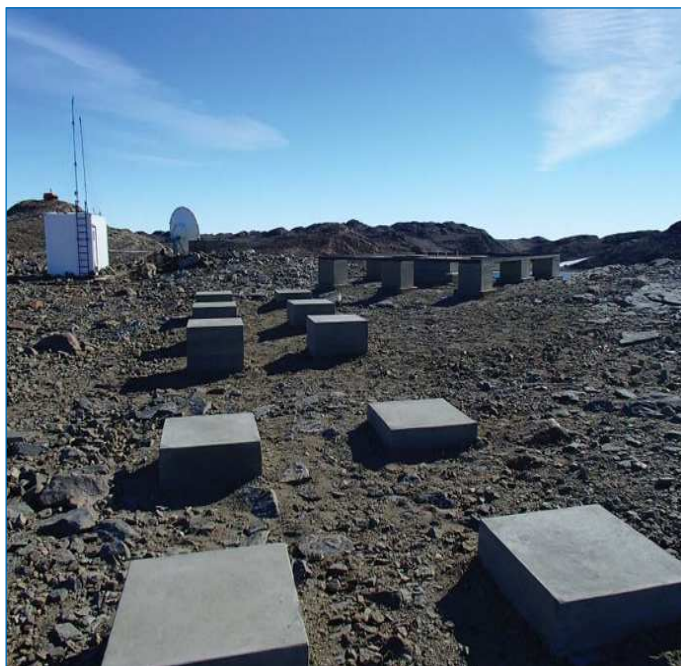
Подготовка площадок для установки нового оборудования для баз станций ГЛОНАСС. Фото В.Е. Кораблева.
