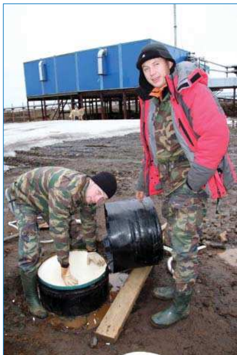
Установка сейсмической станции на архипелаге Земля Франца-Иосифа. Фото Г.Н. Антоновской
