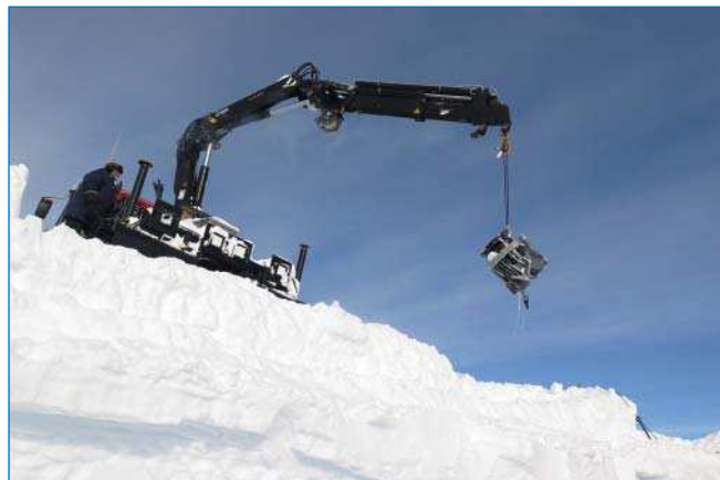
Извлечение РИТЭГа краном.
